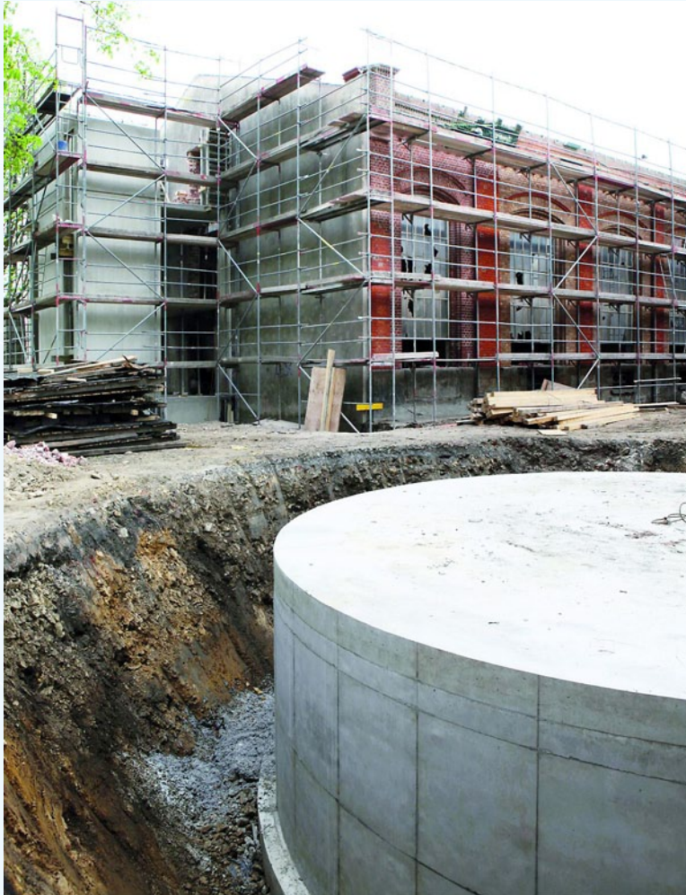
Bild 2. Der Eisspeicher in der Bauphase, Durch- messer ca. 8 m.
