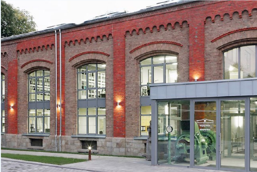
Bild 1. Wasser vom Rhein nach Wuppertal – das Maschinenhaus der Alten Pumpstation Haan. © Bernd Genath
