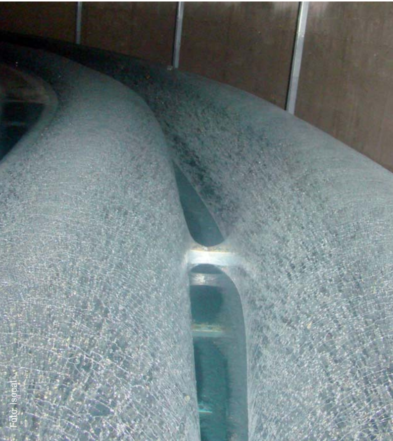
Der Keller-Gletscher: Wer Eis bunkert, kann die Gesetze der Physik nutzen und damit im Sommer kühlen und im Winter heizen.
