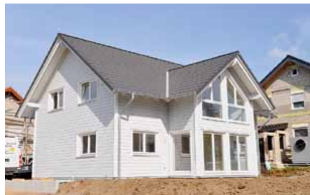
180 m 2 Holzhaus auf den Höhen des Westerwalds. Der Luftwärmetauscher rechts neben dem Haus gehört zur Luft-Wärmepumpe des Nachbargebäudes. Wilfried Marschinke: „Dort wird noch eine Trennwand gesetzt, damit wir das Geräusch nicht so stark hören. Wir haben uns auch aus diesem Grunde gleich von Anfang an für eine geothermische Wärmepumpe von Waterkotte entschieden. Die macht keinen Lärm, hat man uns versprochen.“
