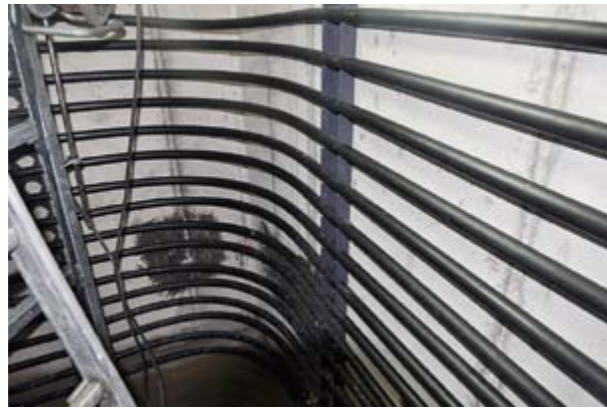
Die Regenerationsschleifen beladen den Behälter mit Solar-energie
