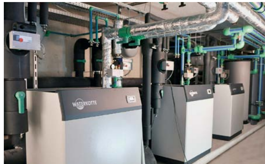
Insgesamt vier DS-Wärmepumpen von Waterkotte mit total 210 kW Heizleistung beliefern den Alt- und den Neubau
