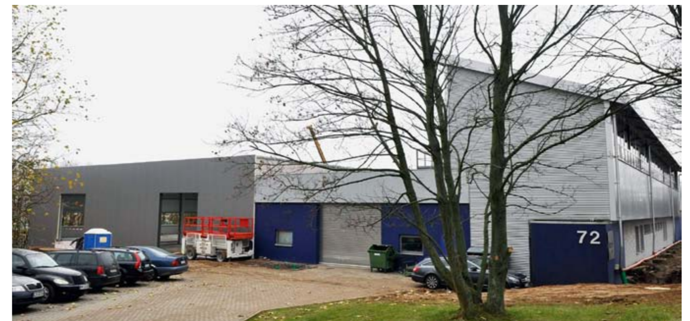
Neubau 3D-Core, Oststraße 74, Herford. Unter der Halle links liegen die Eisspeicher
