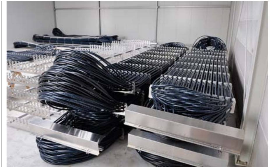
Wickeln der Luftkollektoren vor Ort im Hallenneubau
