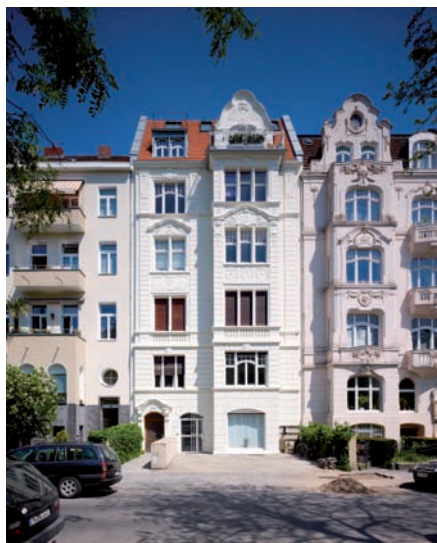
■ Die 100-jährige Gründerzeitimmobilie in Köln. Die Dachgeschosswohnung über zwei Etagen umfasst nach dem denkmalgerechten Umbau 220 m 2 .
